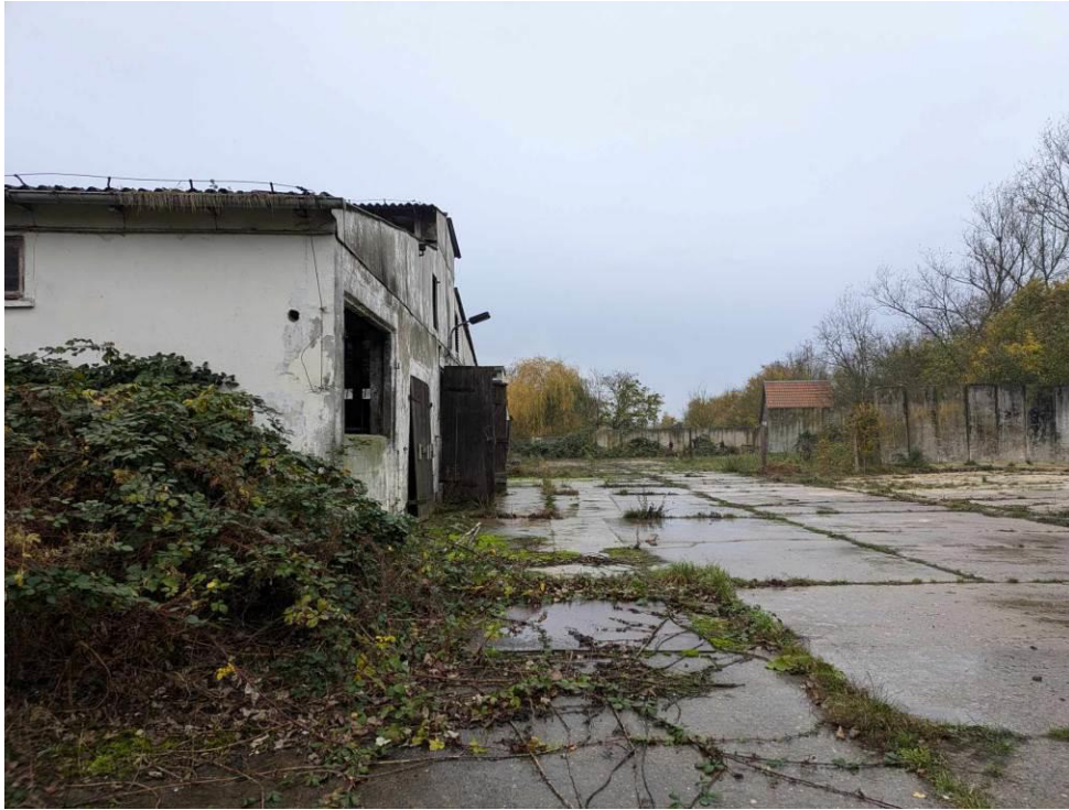
Foto 4-4: Gebäude 2 und 3 – Einflugmöglichkeit durch offene Fensterfront an der nördlichen Giebelseite sowie durch Löcher an der östlichen Fassade.
